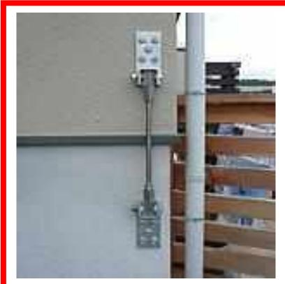
ボルト法:外部からボルトで緊結
