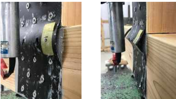
図-11 CFRP プレートの座屈による破壊と、その発生過程
